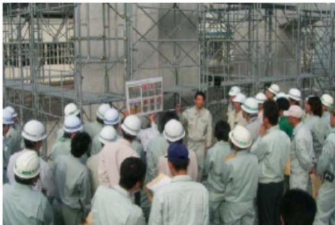
【橋梁下部工の研修状況】
