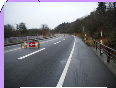
雪が降る前の封鎖状況
