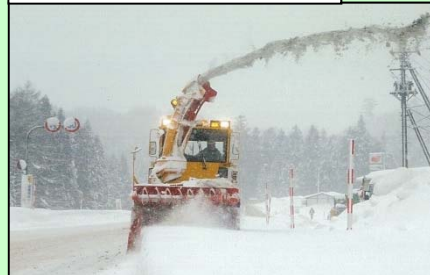
ロータリー除雪による作業状況
