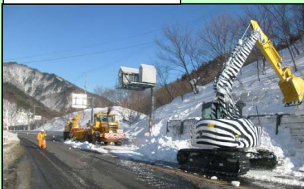
バックホウによる除去状況
