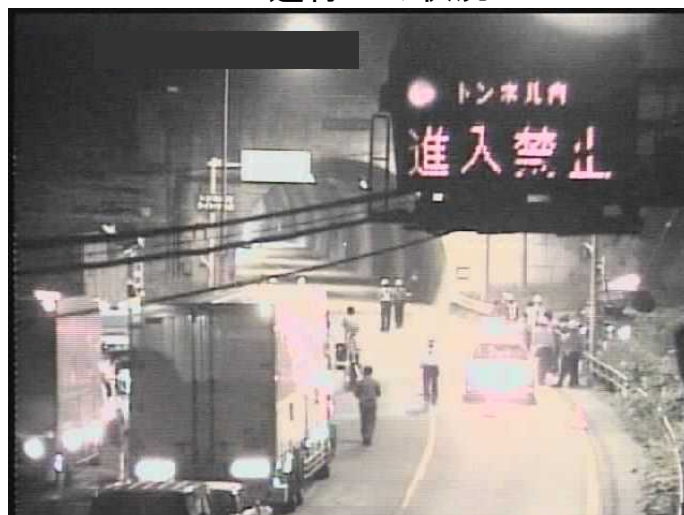
▼通行止め状況▼
