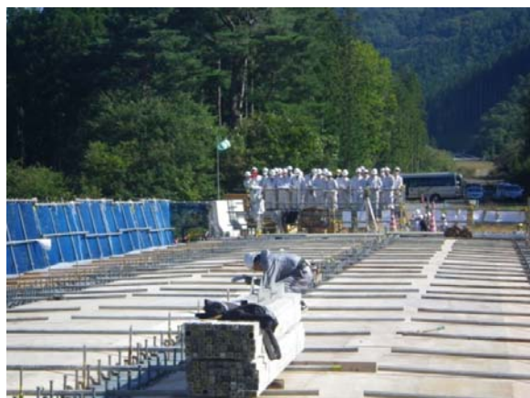
橋梁上部工(コンクリート床版工)を見学
