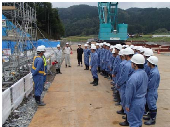
函渠工(アーチカルバート工)を見学
