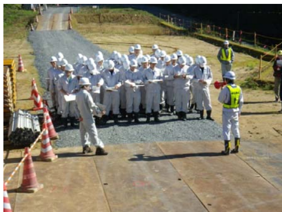
橋梁上部工(コンクリート床版工)現場到着
