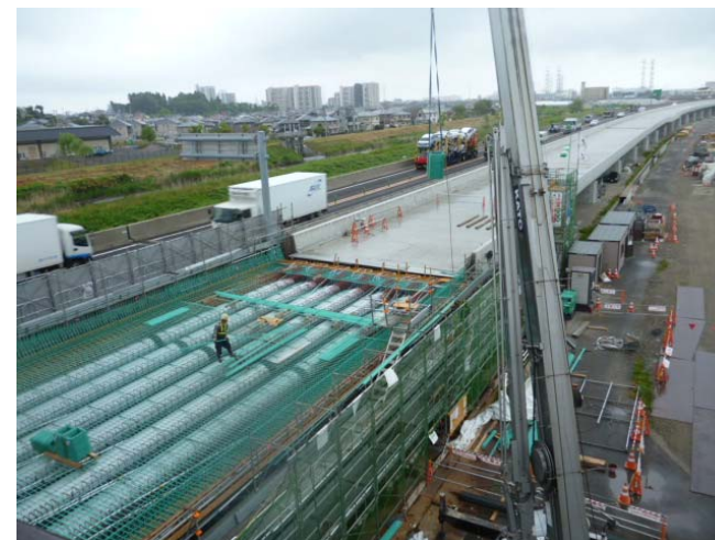
▲仙塩道路の4車線化工事状況
