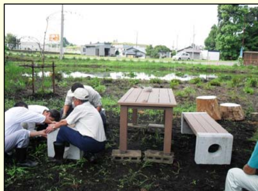
公園内に休憩用のベンチとテーブルを設置しているところです。憩いの場として利用されています。
