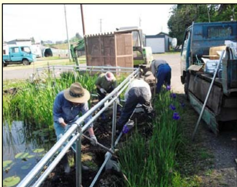
利用者・地域住民の安全対策のために住民の自らの手で防護柵の設置作業を行っているところです。
