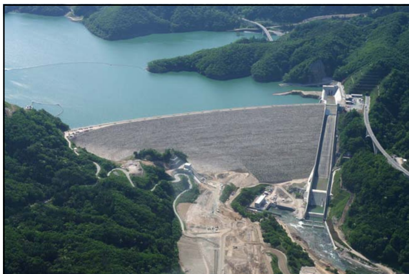
写真-2 胆沢ダム
