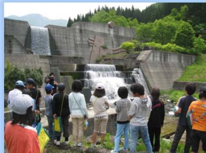
先達川第1砂防堰堤
