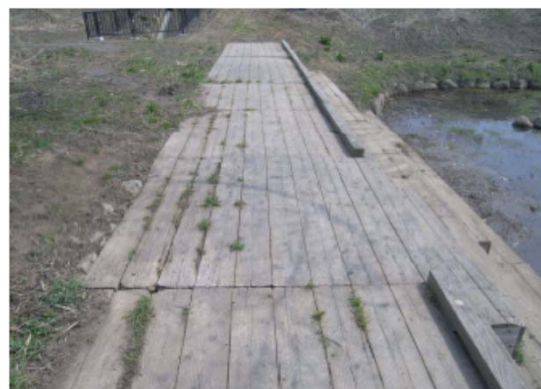
(措置後)デッキの補修
