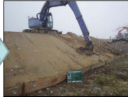
はぎとった分の土砂を補充し、入念な締め固めを行い堤防を復旧する。
