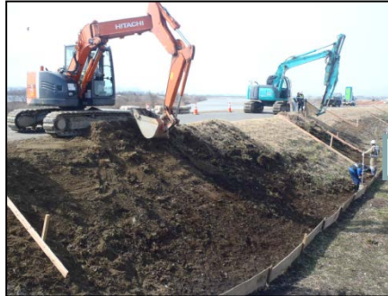
アタッチメント式バックホウにより堤防斜面の表土をはぎとる。
