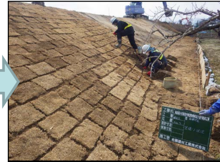
堤防斜面に張り芝による保護を行う。
