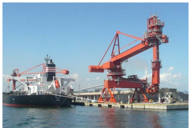
▲石炭運搬船による荷役状況
