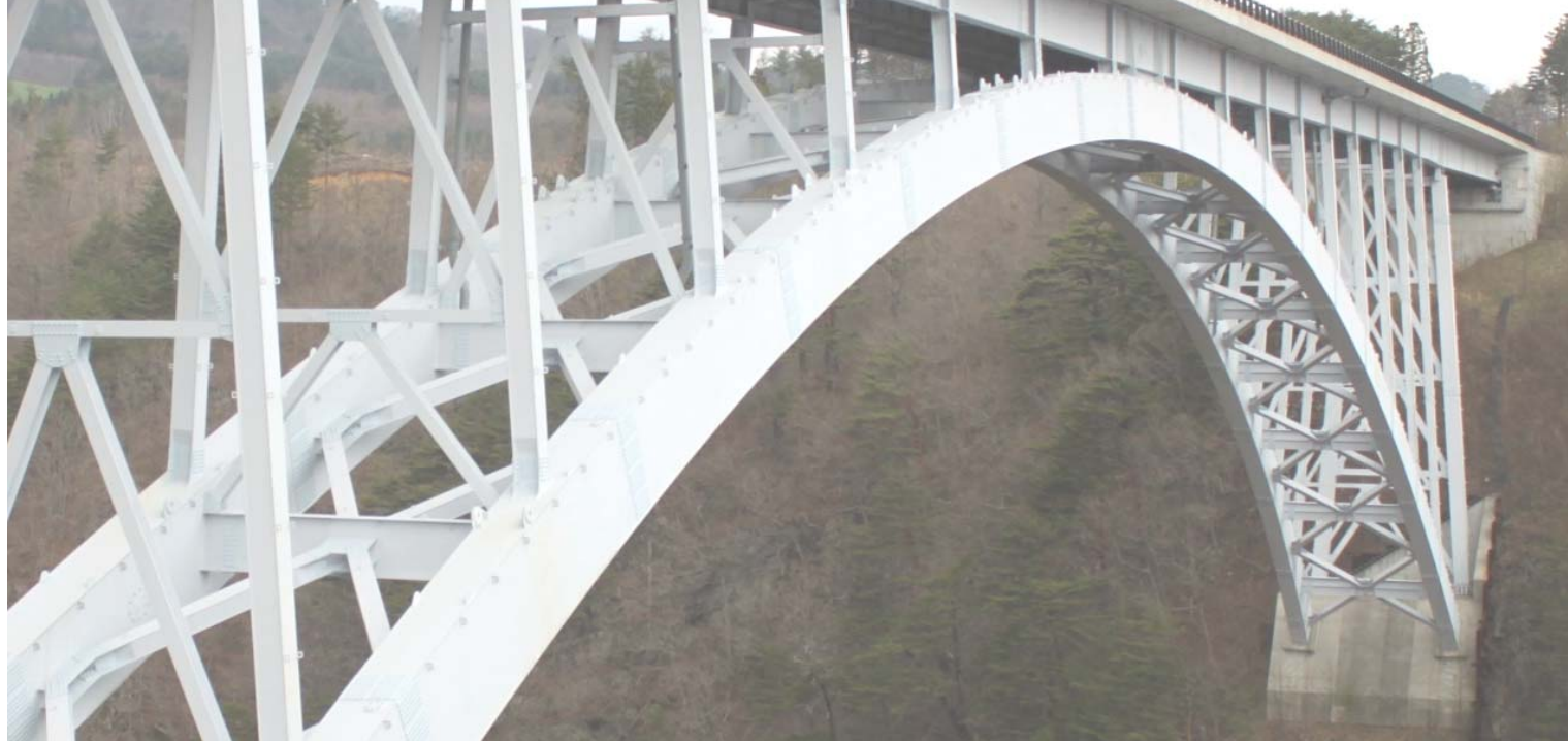
写真：国道45号 思案坂大橋(岩手県下閉伊郡田野畑村)
