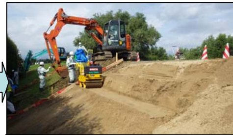
剥ぎ取った分の土砂を補充し、振動ローラー等により入念な締め固めを行い堤防を復旧する。
