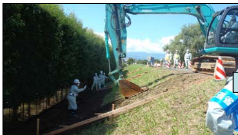
アタッチメント付きバックホーにより堤防斜面の表土をはぎ取る。
