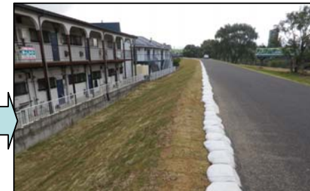
堤防斜面に張芝による保護を行う。
