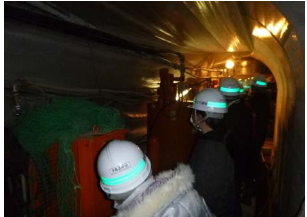
「監査廊」の最下部で、冬期間も行われているボーリング機器による基礎岩盤改良作業を見学
