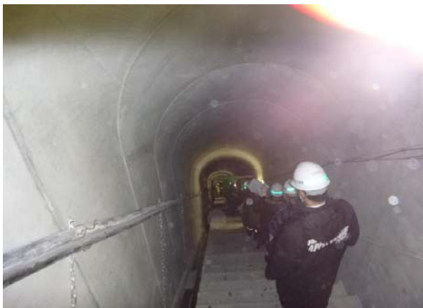
堤体内部の「監査廊」の長い階段を最下部へと降ります
