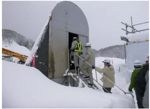
堤体上部から、いよいよ津軽ダム堤体の内部へ入場
