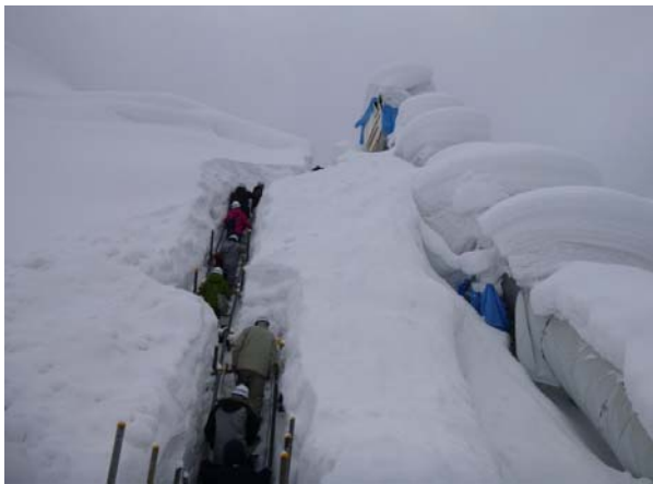
2mを超える雪の壁の中、津軽ダム堤体に向かう参加者
