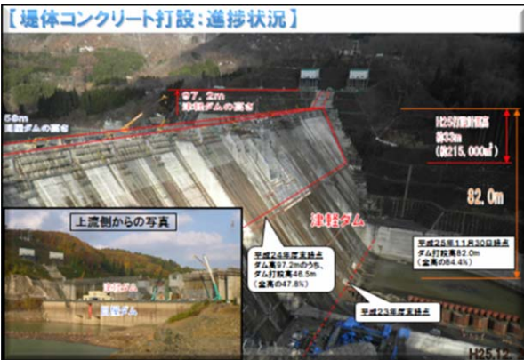
【堤体コンクリート打設:進捗状況】
