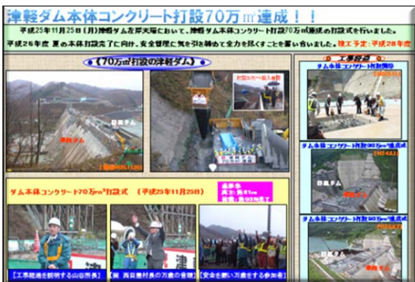
【津軽ダム本体コンクリート打設70万m³達成】
