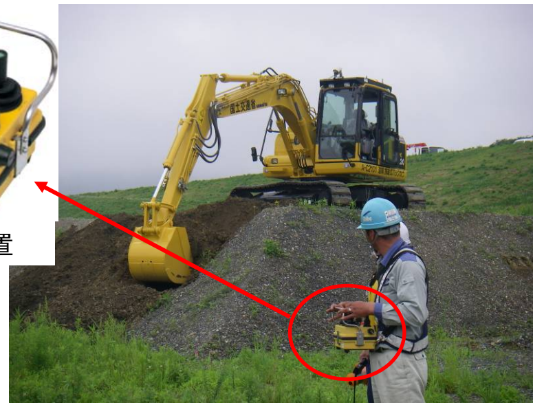
遠隔操作の状況 (訓練)
