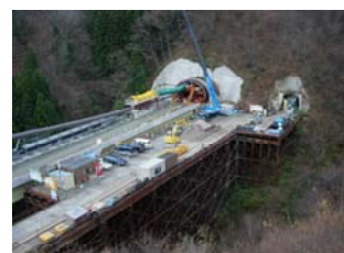
平成25年 工事中の栗子トンネル（仮称）
