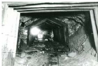
明治期 改修前の栗子隧道内部
