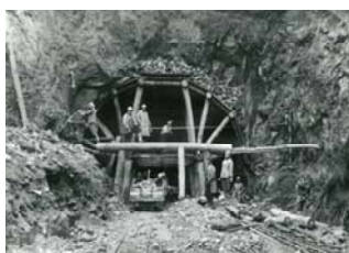
昭和9年 工事中の栗子隧道（福島側坑口）
