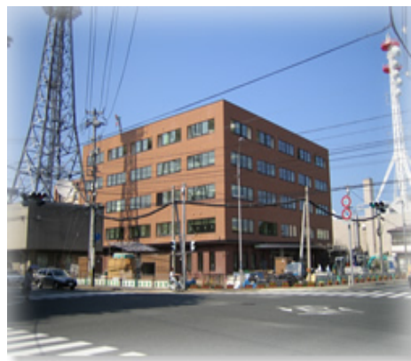
岩手河川国道事務所外観
