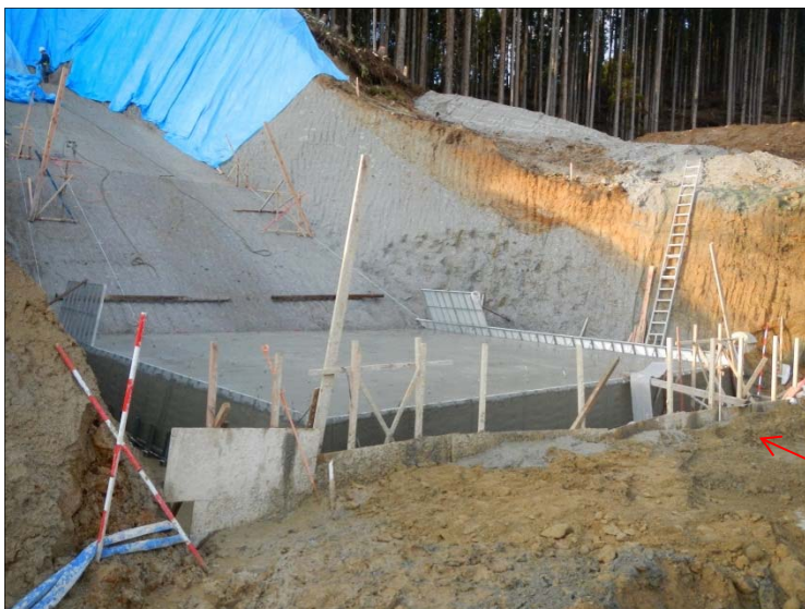
コンクリート打設状況(12月3日撮影)
