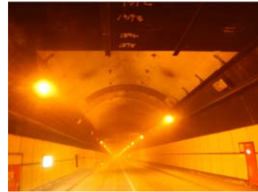
天井板撤去後の状況
