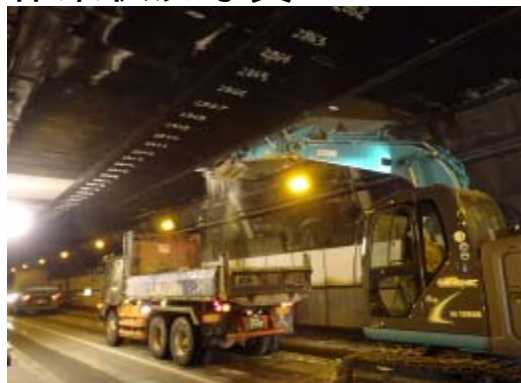
天井板撤去状況
