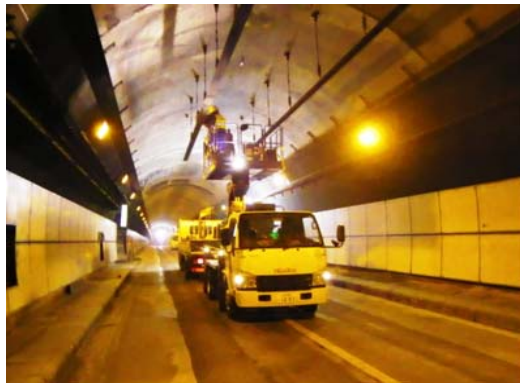
吊り金具撤去状況
