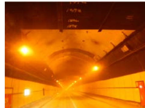
天井板撤去後の状況
