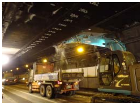
天井板撤去状況
