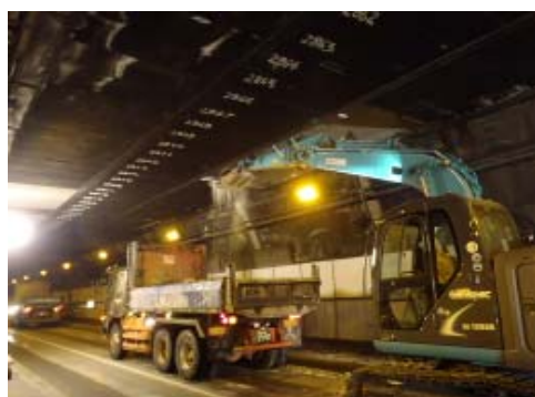
天井板撤去状況
