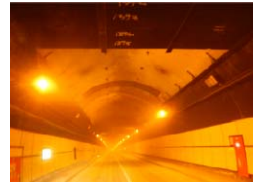
天井板撤去後の状況
