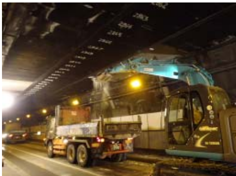
天井板撤去状況
