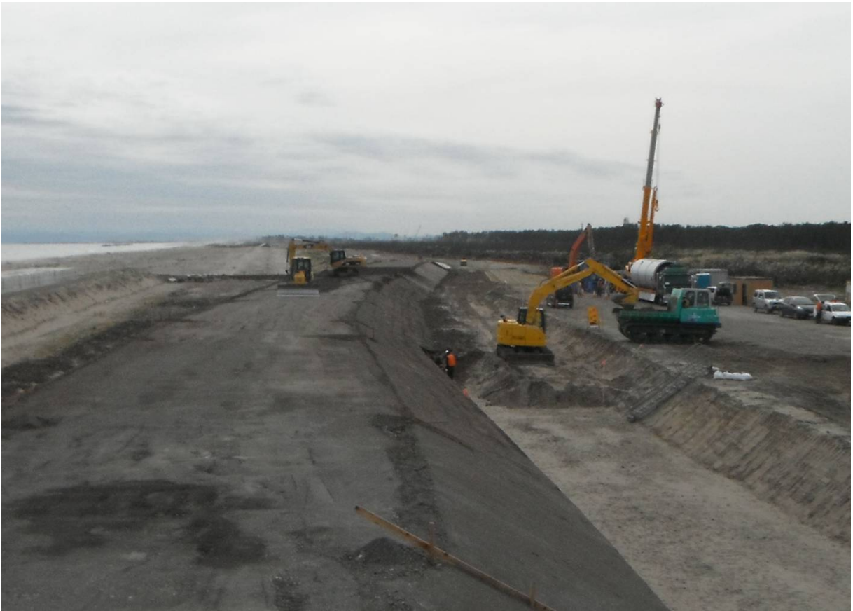
深沼工区復旧工事の施工状況：10月4日
