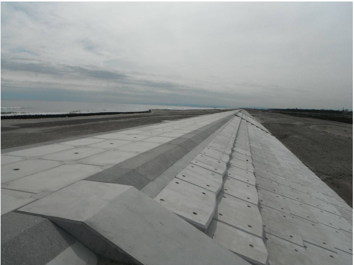
深沼北工区の完成状況：10月4日
