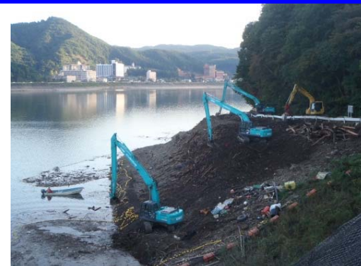
流木撤去状況
