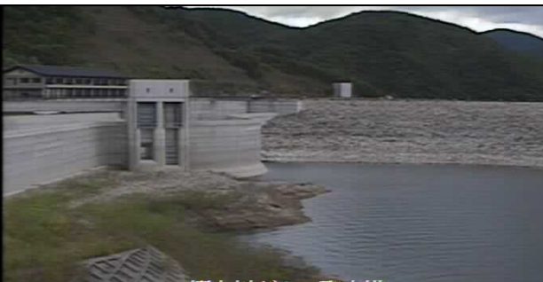
降雨開始から貯水池の水位が約1.9m上昇しました。
