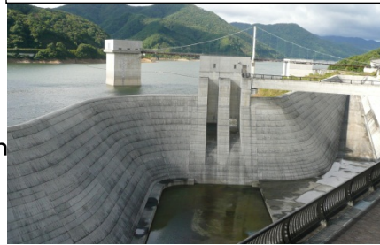
摺上川ダムの状況[H25.10.17 9:50]
