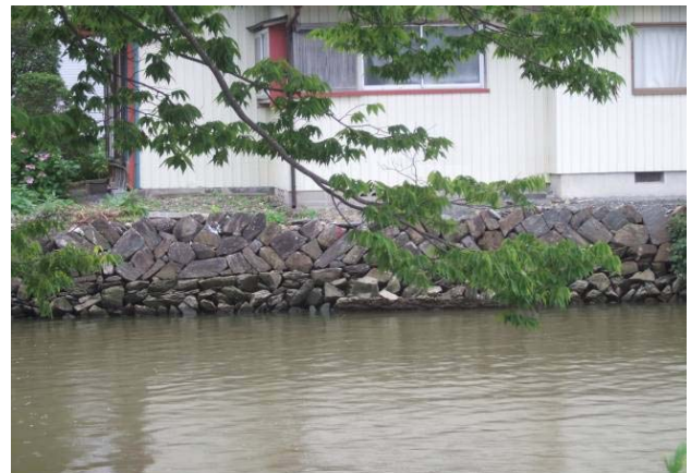
左岸井内付 いない 近の石積み
