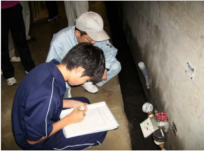
▲ダム堤体内(監査廊)での浸透流観測(圧力を測定)
