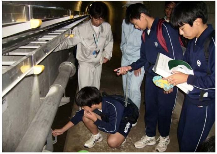
▲ダム堤体内(監査廊)での浸透流観測(流量を測定)
