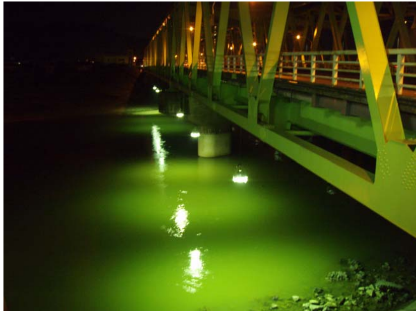
写真：国道4号 大仏橋（福島市舟場町）
