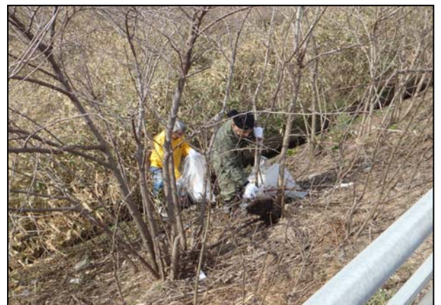
■法面清掃の様子
