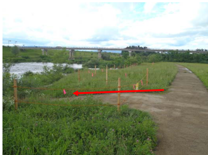
トラロープにて進入禁止措置
