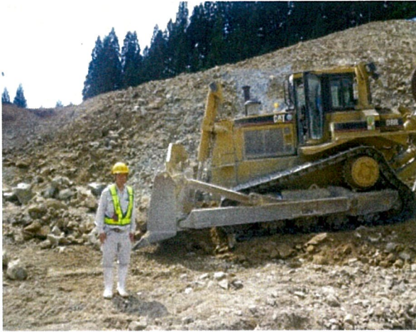
月見堂改良工事
