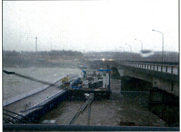
割山地区下部工工事
