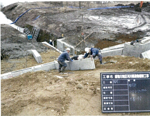
雄物川地区河川構造物補修工事
