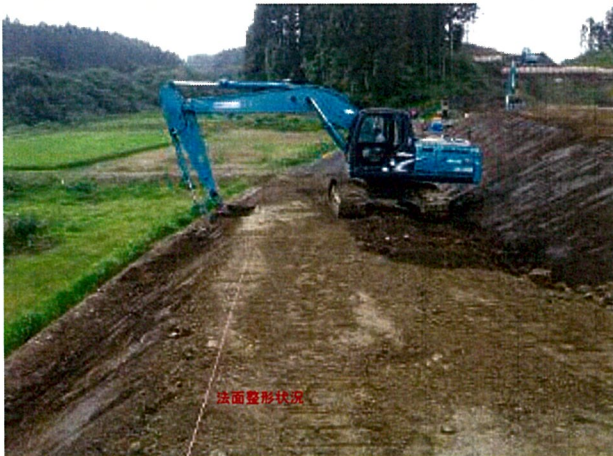
中山道路改良工事
