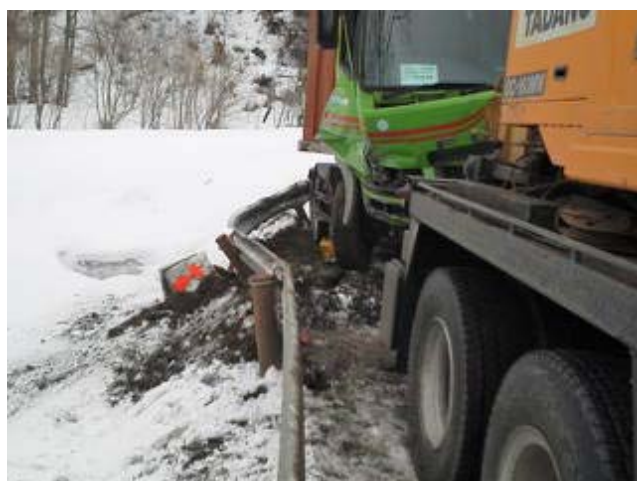
ガードレール等の損傷状況
