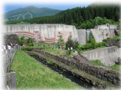
先達川第1砂防堰堤
