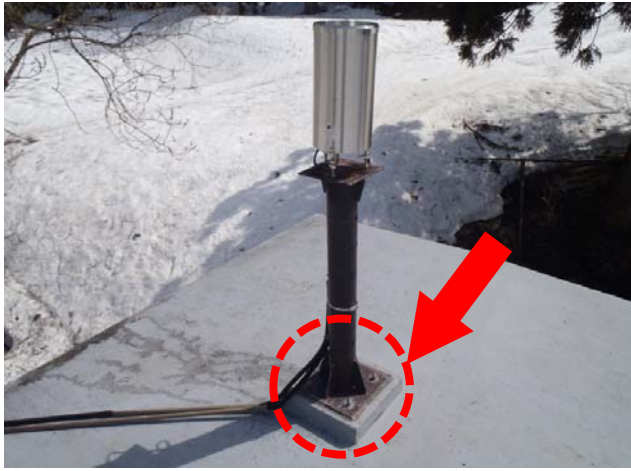
大柳雨量観測所 雨量計支柱アンカーボルトゆるみ
