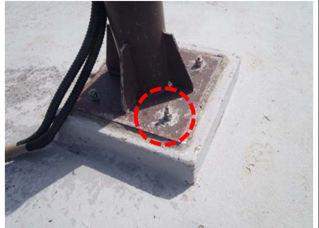
大柳雨量観測所 雨量計支柱アンカーボルトゆるみ
