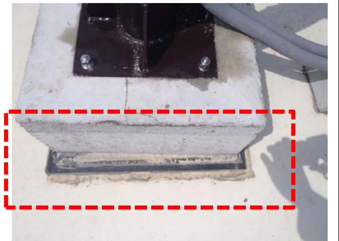
入道森雨量観測所 雨量計基礎の移動（ズレ）
