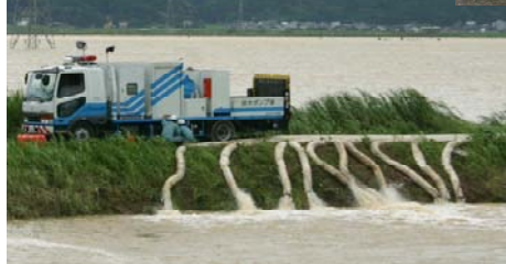
← 排水ポンプ車
