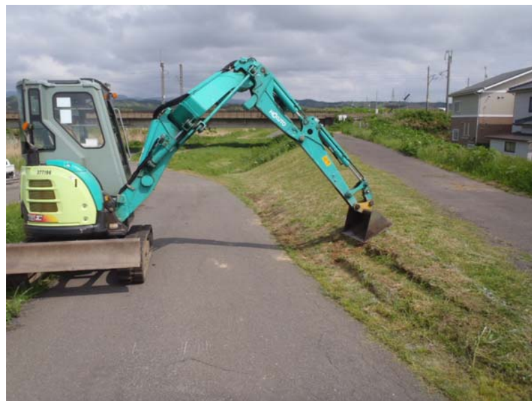
写真②(施工中) バックホーによる法面整形
