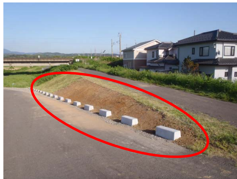
写真③(施工後) 新たに駒止を設置し、車両の進入を防ぐ(芝張り未施工)
