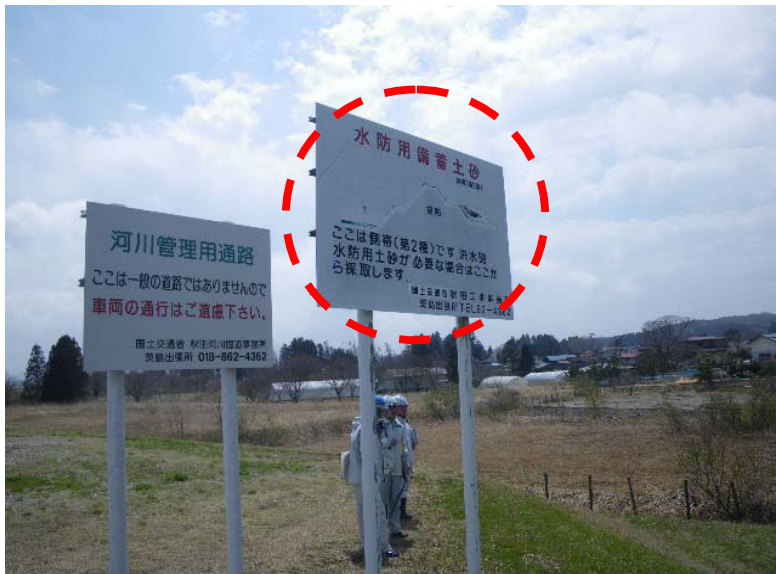
▲ 説明看板が不鮮明で分かりづらい (河川利用者への説明不足につながり危険)
