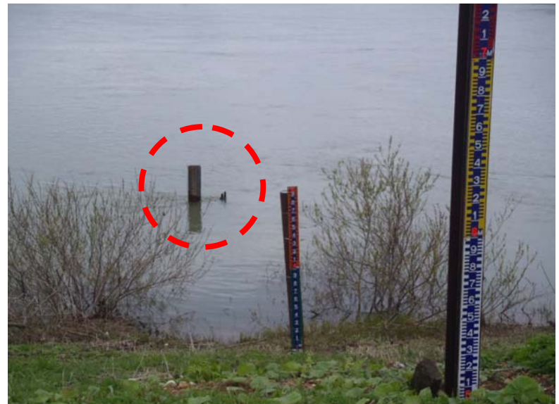
▲ 河道内の量水標が流出 (目測できる指標がないため、増水等への対応が遅くなり危険)
