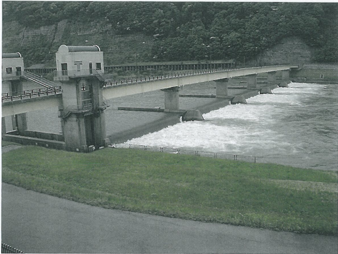
ゲートが起立した 最上川さみだれ大堰（5月23日）
