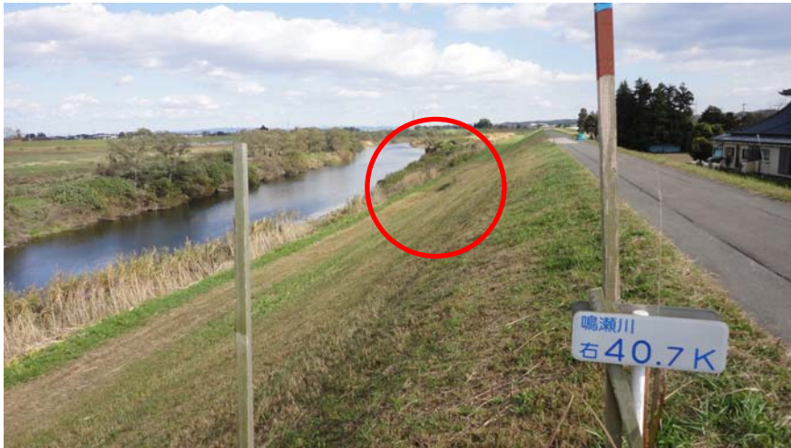
堤防天端から見た法面状況
