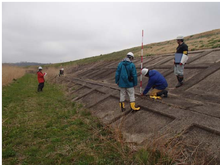
目視点検状況写真
