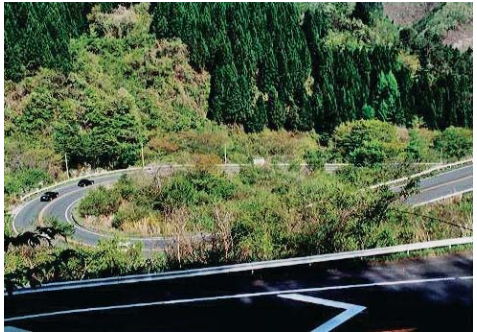
▲現道の線形不良箇所
