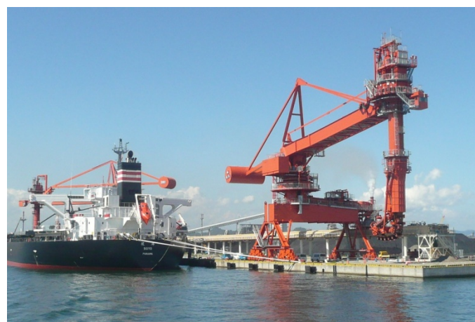
▲石炭輸送船による荷役状況
