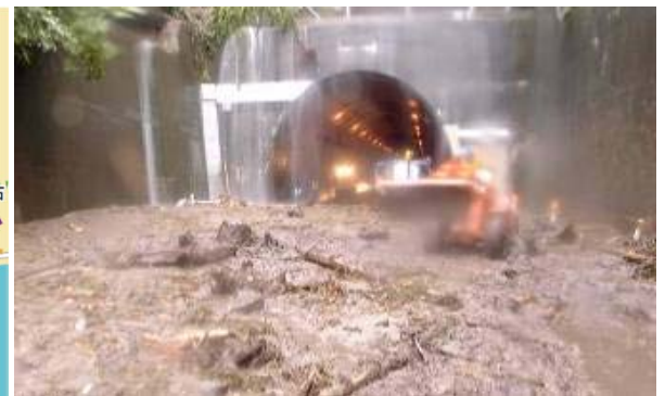
▲羅生トンネル北口における切土法面崩落(H14.7.11)
