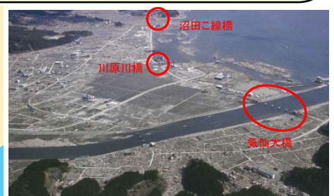
▲陸前高田市内の被災状況
