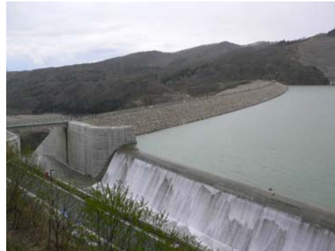
試験湛水状況(平成25年5月7日) 洪水時最高水位到達
