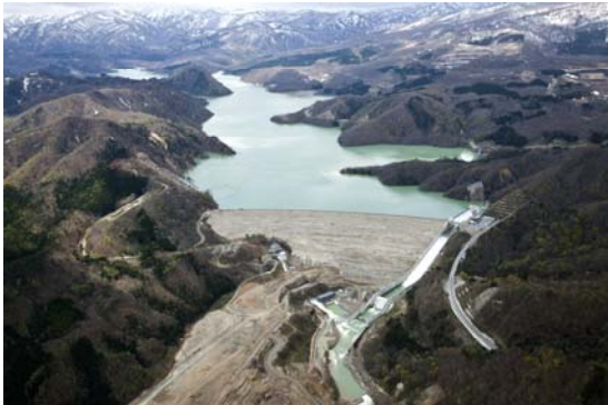
洪水時最高水位を迎えた胆沢ダム (平成25年5月)
