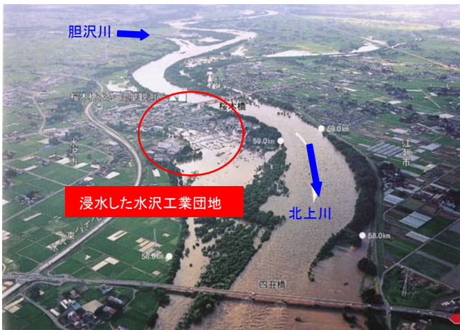
平成14年7月 出水状況(胆沢川合流点付近)
