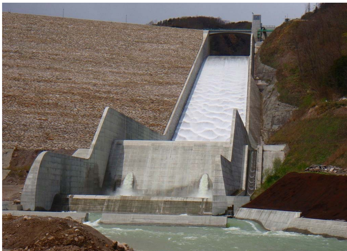
洪水吐きからの放流状況
