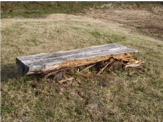
(措置前)ベンチの損傷
