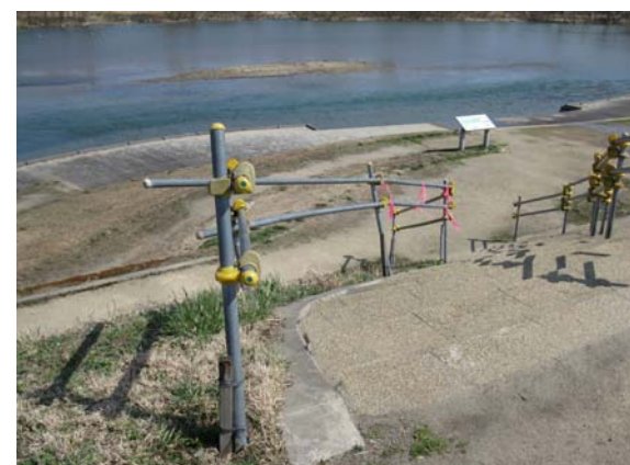
(措置後)階段部の手すりの再設置
