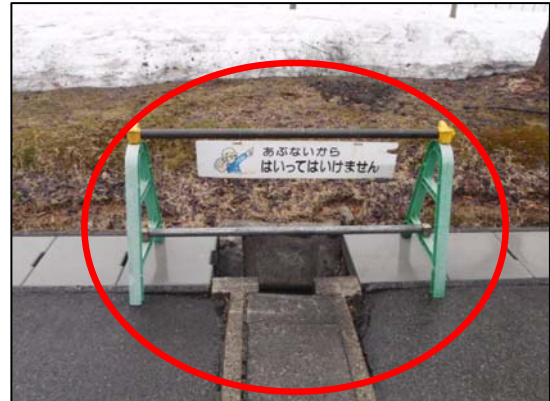
バリケードを設置した。
