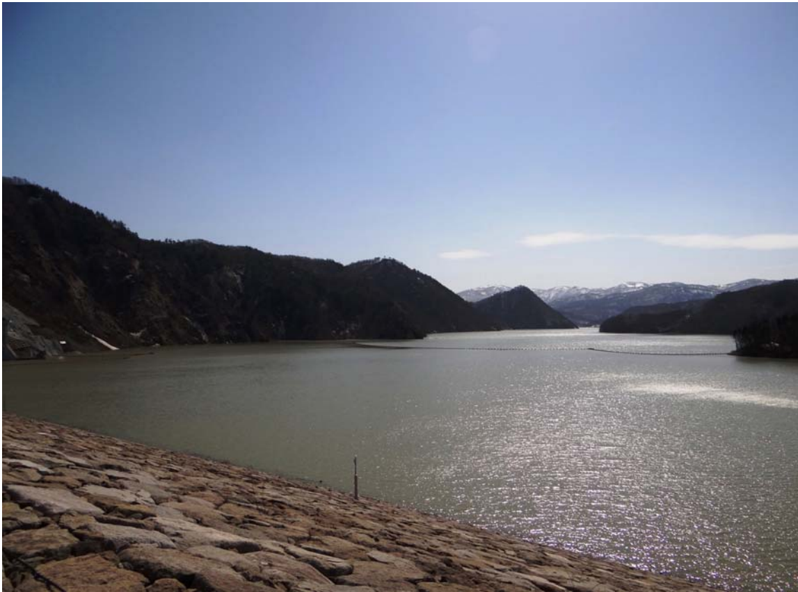
胆沢ダム堤頂から奥州湖を望む
