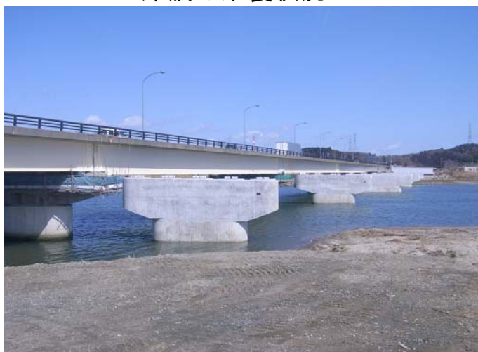
橋脚の完成状況
