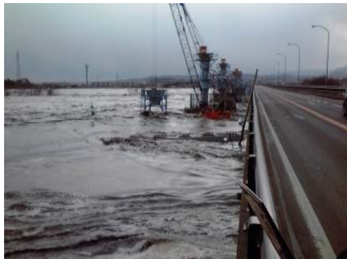
津波の来襲状況
