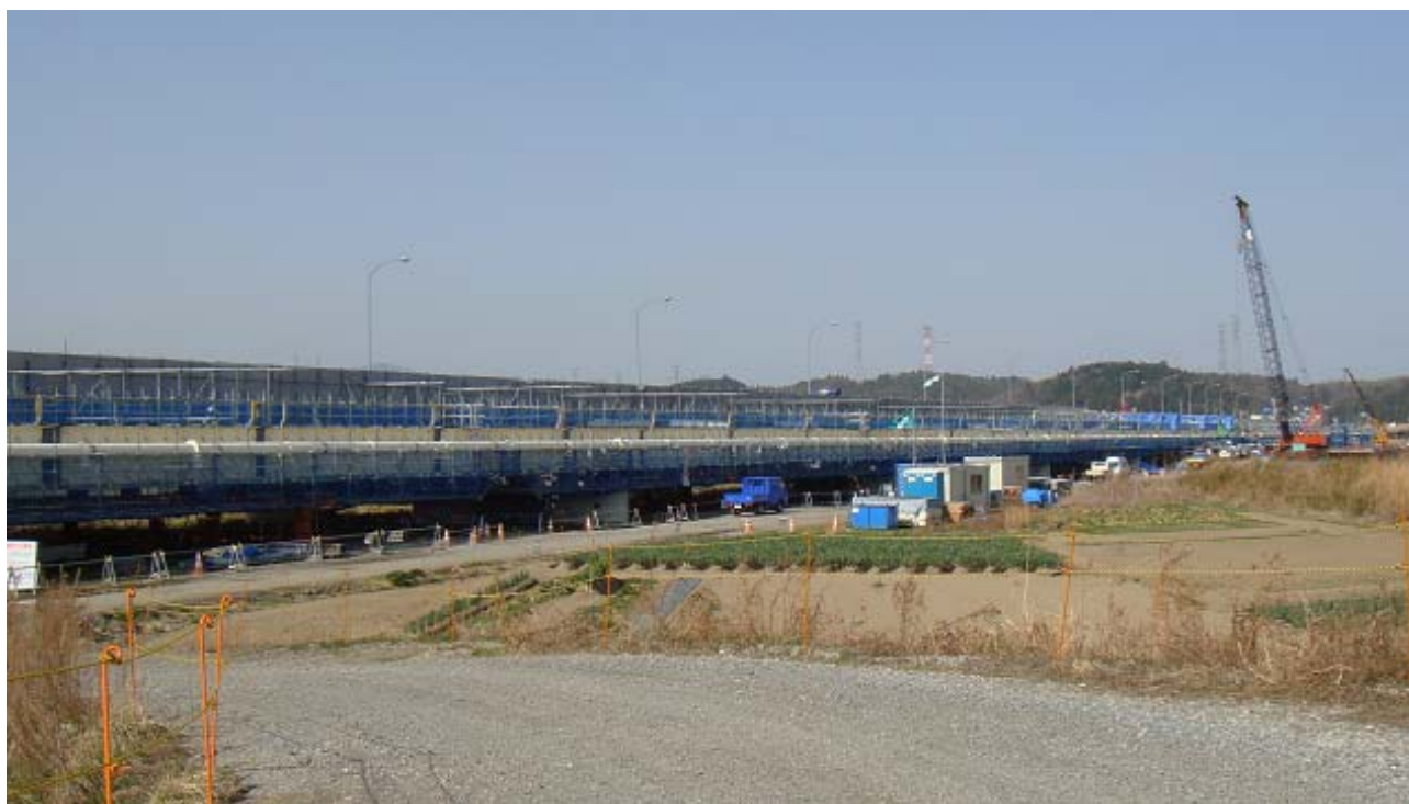
桁の完成写真
