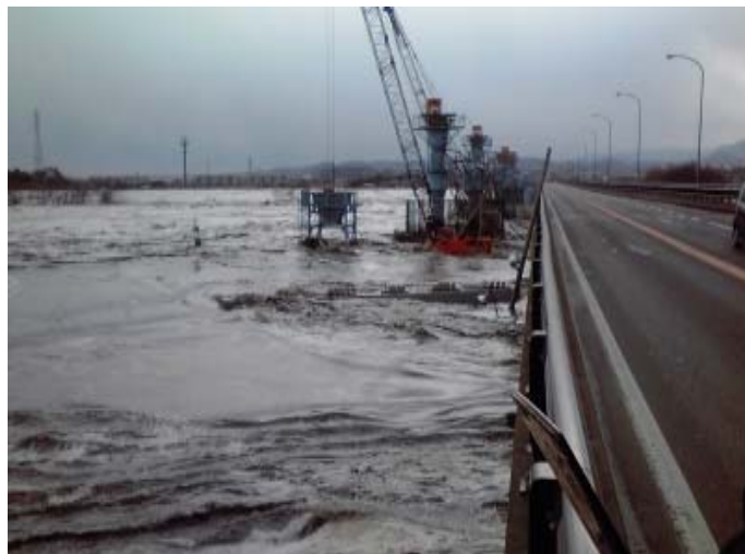
津波の来襲状況
