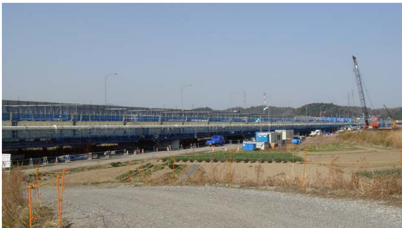
桁の完成写真
