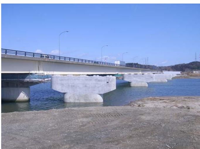
橋脚の完成状況
