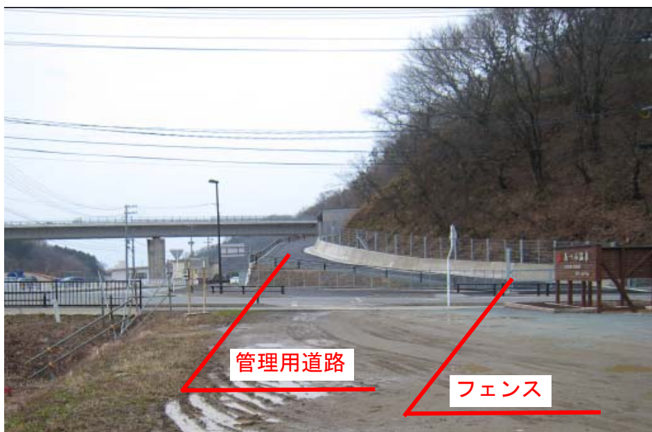
▲あつみトンネル南管理用道路 現地写真
